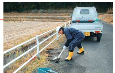
散歩道の整備
