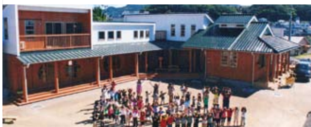
▲写真は、木造公共施設等整備補助（かごしま木づかい推進事業）や福祉医療機構及び本会の貸付資金制度を活用された「まくらぎ保育園」（枕崎市）です。
